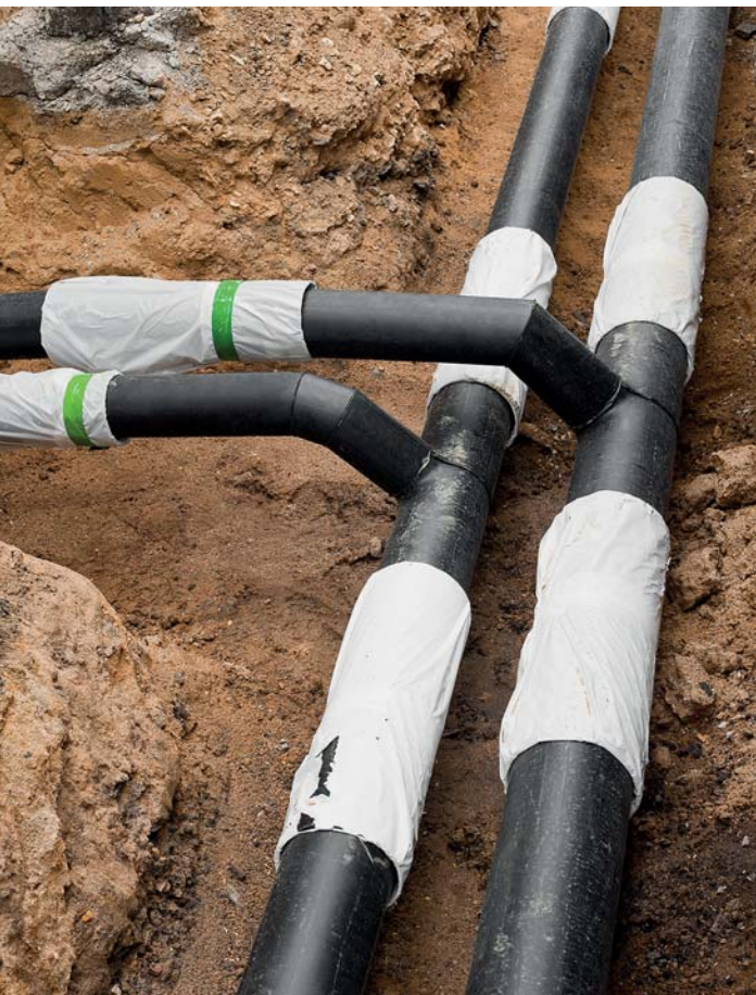
Messadern-Anordnungen in gedämmte Mantelrohrsysteme für Fernwärme
