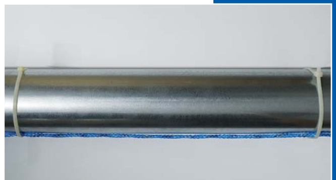
Montage an horizontal verlaufenden Rohren
