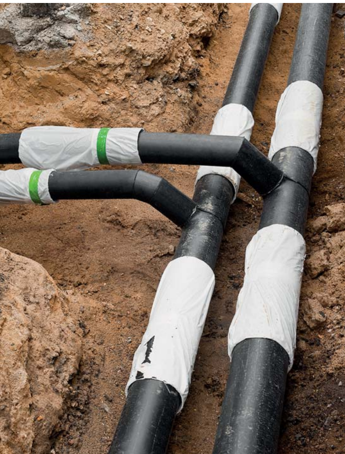
Messadern-Anordnungen in gedämmte Mantelrohrsysteme für Fernwärme
