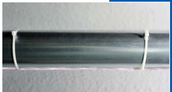
Montage an horizontal verlaufenden Rohren
